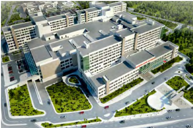
ESKİŞEHİR ŞEHİR HASTANESİ
